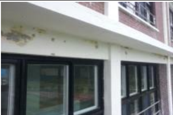
외부 도색 공사 전 사진
