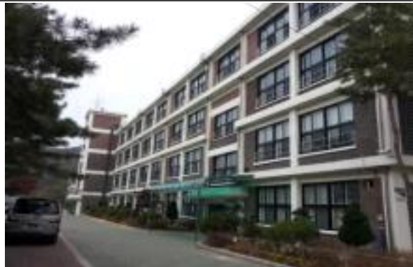
외부 도색 공사 후 사진
